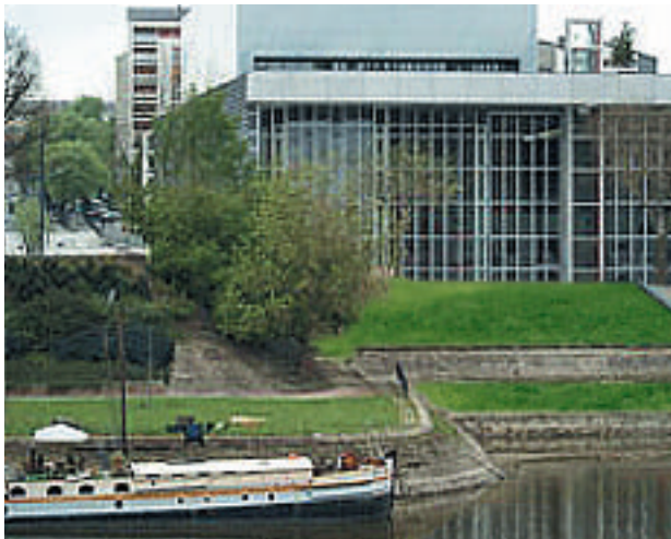
Bâtiment construit selon les normes HQE (Haute Qualité Environnementale), Le Quai ouvre de nouvelles perspectives à l'autre rive de La Maine, le quartier populaire de la Doutre.
