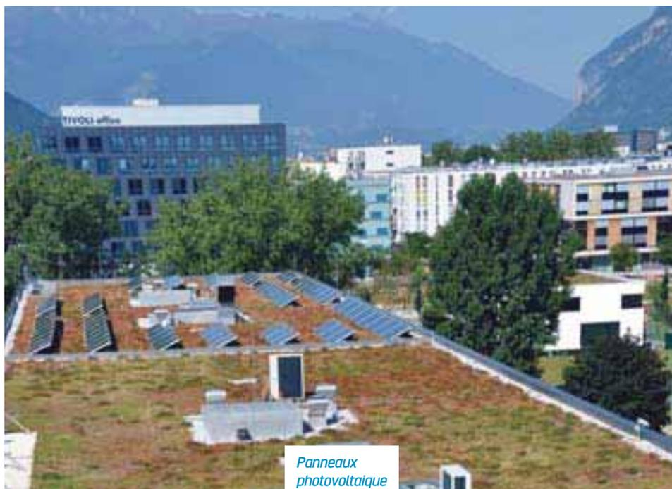
Panneaux photovoltaïques et terrasse végétalisée sur le toit d'un immeuble d'Innsbruck.
