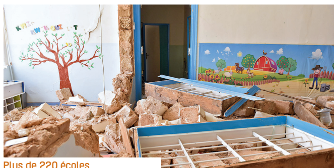
Plus de 220 écoles endommagées ou détruites.
